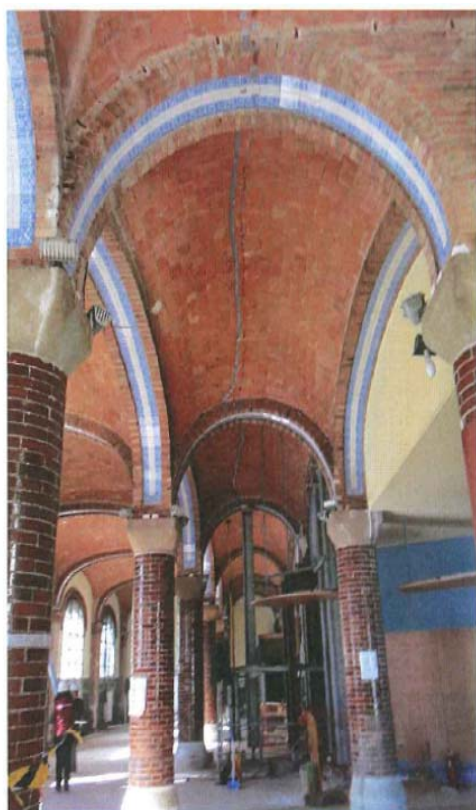
Foto 2. Bóveda instrumentada próxima al apeo.
