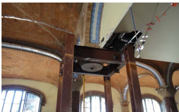
Foto 3. Pilar apeado y fibra óptica en la bóveda.
